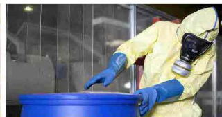
Rimozione Eternit - Costi
